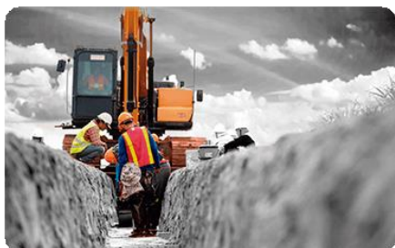
Valas e Escavações
